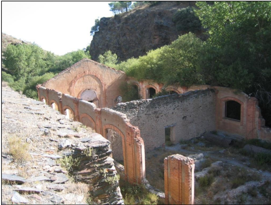
Figura 3: Estado actual del edificio de la central El Canal de Natalio Zurita.
