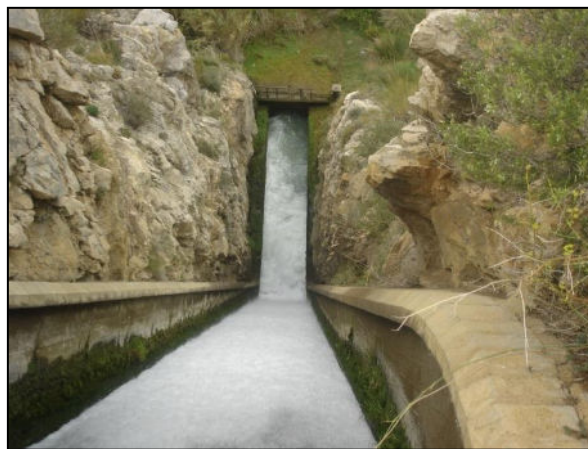
Figura 1: Salto de la central Partidor de Cañizares.
