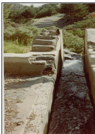
Figura 2: Azud y toma de la central Sabinar.
