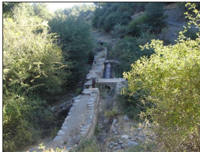
Figura 4: Canal de Alhorí I.
