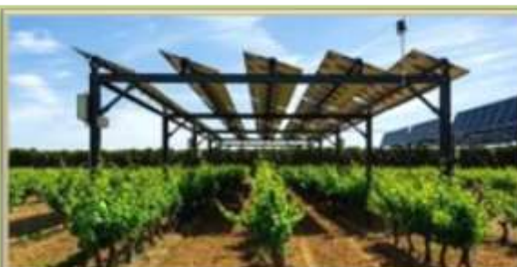
Finca González Byass Daramezas, 40 kW de energía solar fotovoltaica, en Toledo, España
