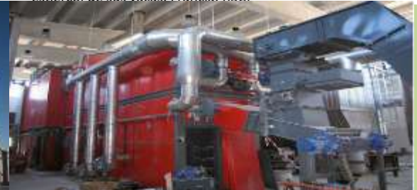
Planta de producción de calor y energía a partir de virutas de madera virgen procedentes de la poda de olivos de Salento. Italia, (Meridaunia)
