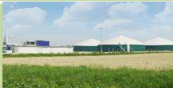
Central de producción de energía mediante gasificación químico-biológica de biomasa en Bulgaria (UF)
